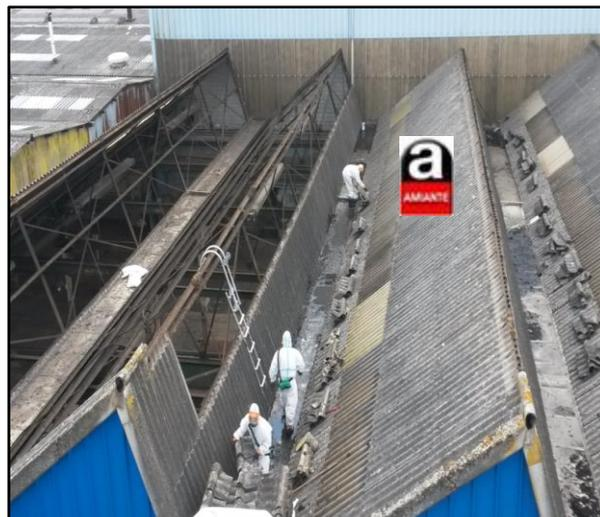
A l'issue des travaux, les matériaux amiantés sont déposés
