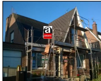
Retrait de l'ensemble des ardoises en toiture. Mise à disposition par le couvreur d'un échafaudage, d'un monte-charge et de moyens de sécurité aux normes.
