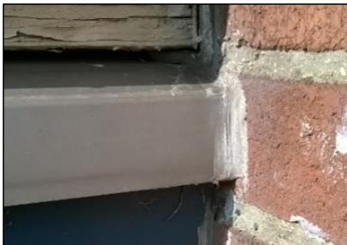
Dépose par dévissage soigneux des allèges en glasal.
