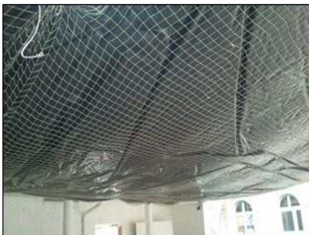
Installation du filet de protection antichute en sous-face de la toiture
